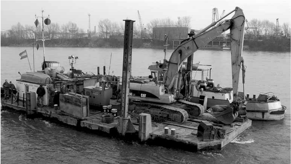
Úszó munkagép a budafoki-gázlóban, a kotró kanalában a rombolóbomba 6
