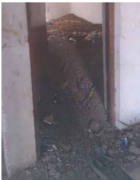
3. kép. Így halmozták fel az épületek helyiségeiben az alagútrendszer kialakítása során kitermelt földet. Ennek oka az volt, hogy a légi felderítés elől rejtve akarták tartani mind az építés tényét, mind pedig a lejárát helyét, nehogy egy légicsapás a lejárátot rejtő épületet megsemmisítse (a szerző fotója).
