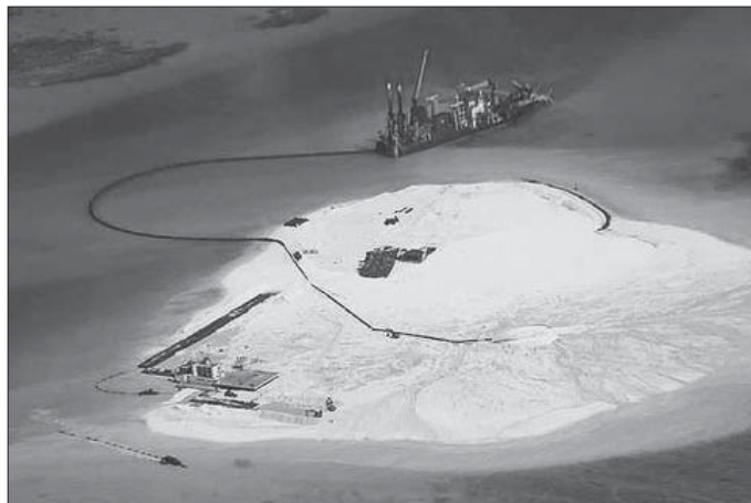
Építkezés a Johnson South-zátonymnál
