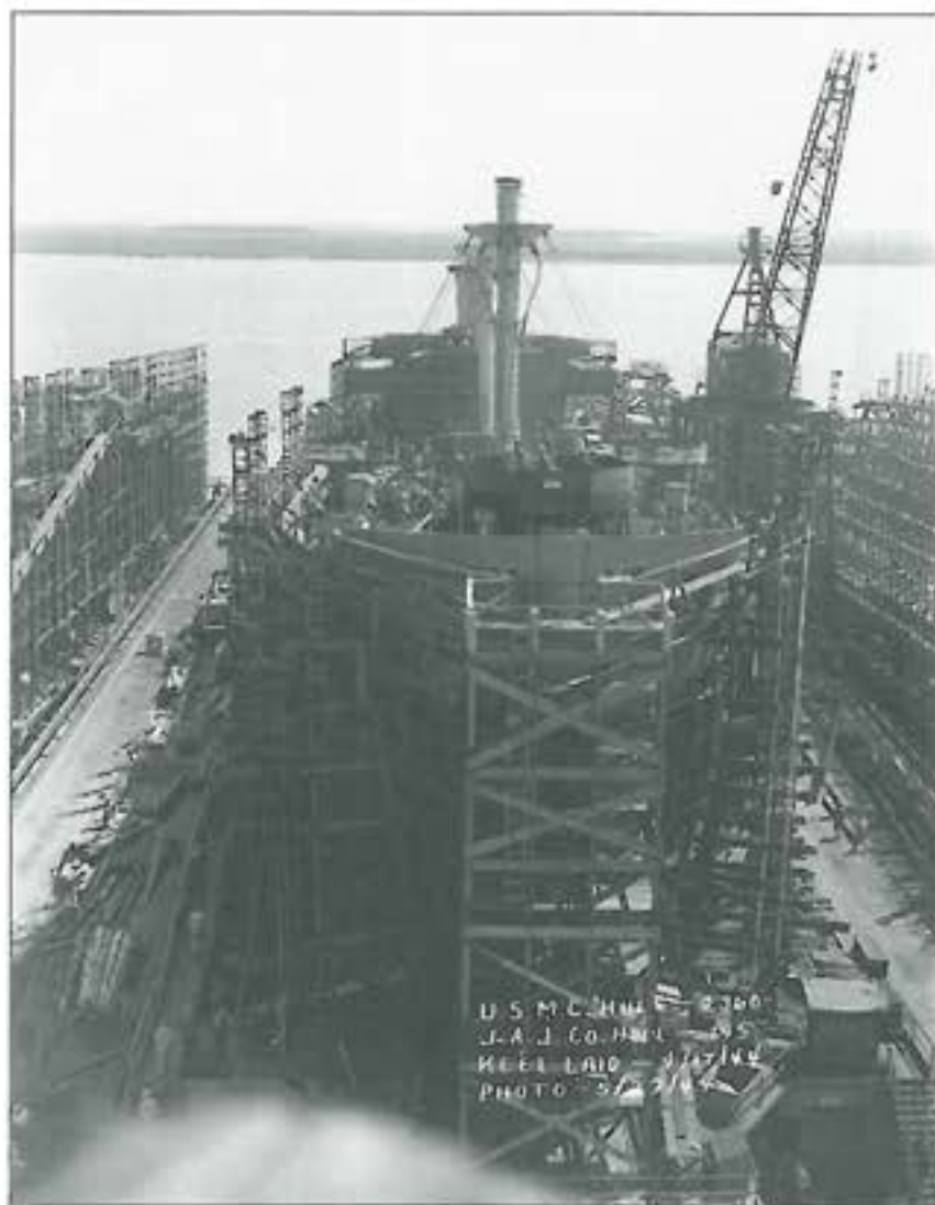
1. ábra. Körbeállványozott épülő LIBERTY
