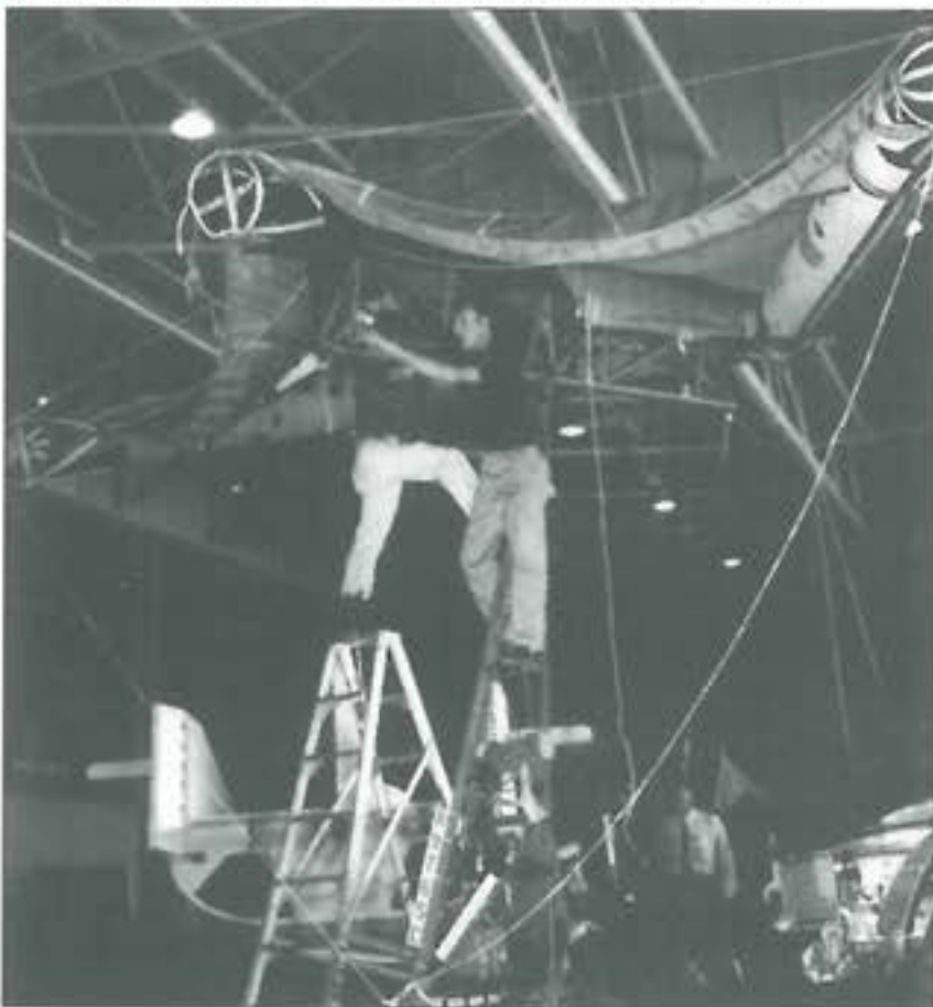
25. ábra. Felszerelik a felfújható szárnyat a Parasevre 1963-ban a NASA Repülési Kutatóközpontjában. A háttérben felismerhető az M2-F2 emelőtest. – NASA
