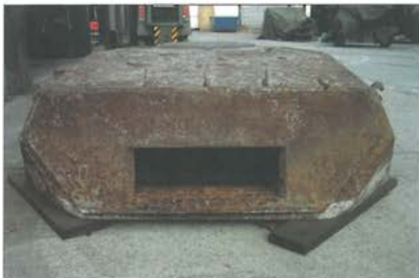
6. ábra. A páncélkupola állapota helyreállítás (restaurálás) előtt
