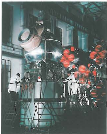
21. ábra. Jól látható a felfújható légszilip a Voszod űrhajó kabinjának oldalán
