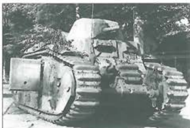
3. ábra. A francia Char B1bis járműből átépített Pkw B2(F) változat
