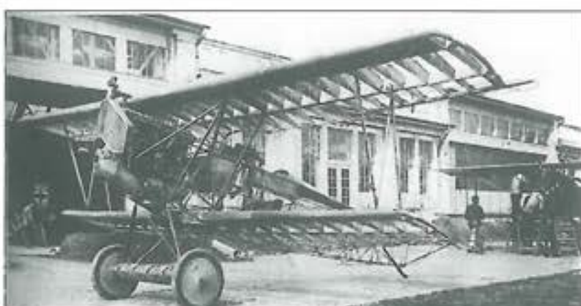
8. ábra. D.VII-eseket szerelik össze Mátyásföldön. Jól látható a Fokker hegesztett acélcső szerkezete a törzsnél és a vezérsíkoknál. A nagy szilárdságú könnyűszerkezet alkalmazásával a repülő teljesítménye jelentősen növekedett
