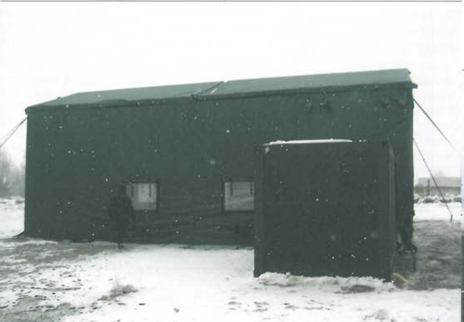
12. ábra. Haditechnikai karbantartó konténer telepítése dupla sátorral
