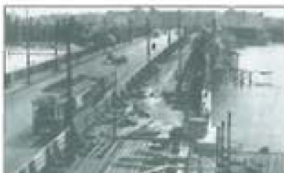
3. ábra. A híd szélesítése déli irányba
