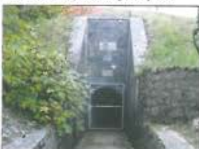
12. ábra. A kiépített alagút bejárata
