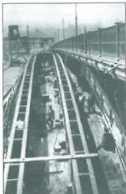
4. ábra. A híd szélesítése a budai áthidalásoknál 1935-ben
