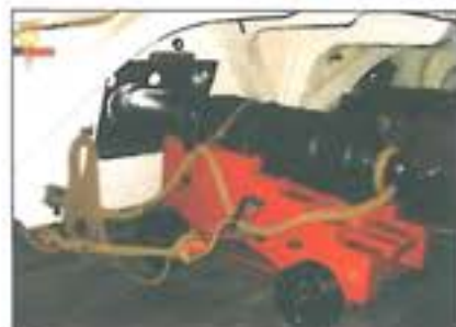
1. ábra. Hagyományos hajóágyú és „lépcsős” lafetta (Orlogsmuseet Kopenhága, a szerző felvétele). Alul láthatók az oldalirányításhoz használt kötelek és csigák, valamint a cső emelkedésének beállítása egy faék segítségével
