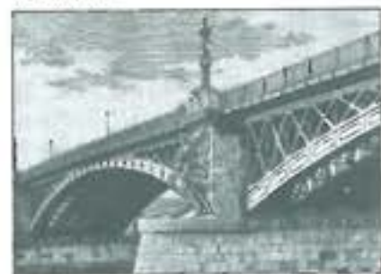
5. ábra. A híd eredeti sűrű rácsos szerkezete
