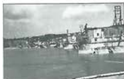
20–21. ábra. Gázcsőátvezetés építése a hídpilléreken
