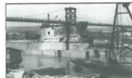
23. ábra. Gázcső és közművek átvezetésére szolgáló híd
