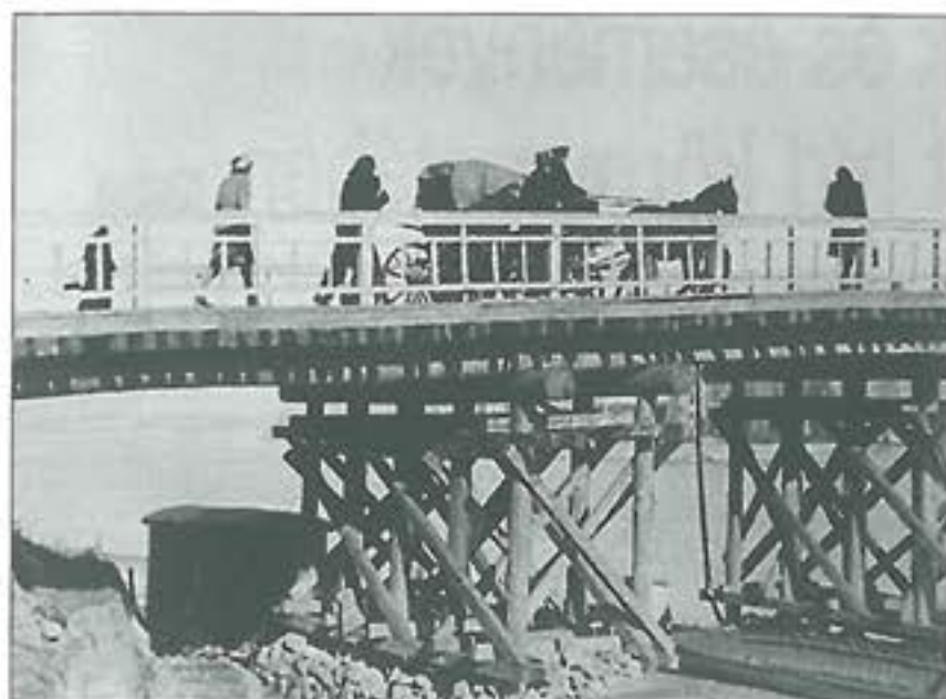
17. ábra. A cölöphíd feljárója
