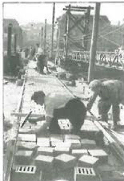
29. ábra. Az új híd burkolása, háttérben a gázcsőhíd
