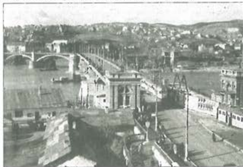
30. ábra. Félkészleiségben átadott híd a közművek elhelyezése után
