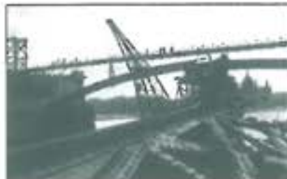
31. ábra. Az új híd íveinek beemelése úszódaruval
