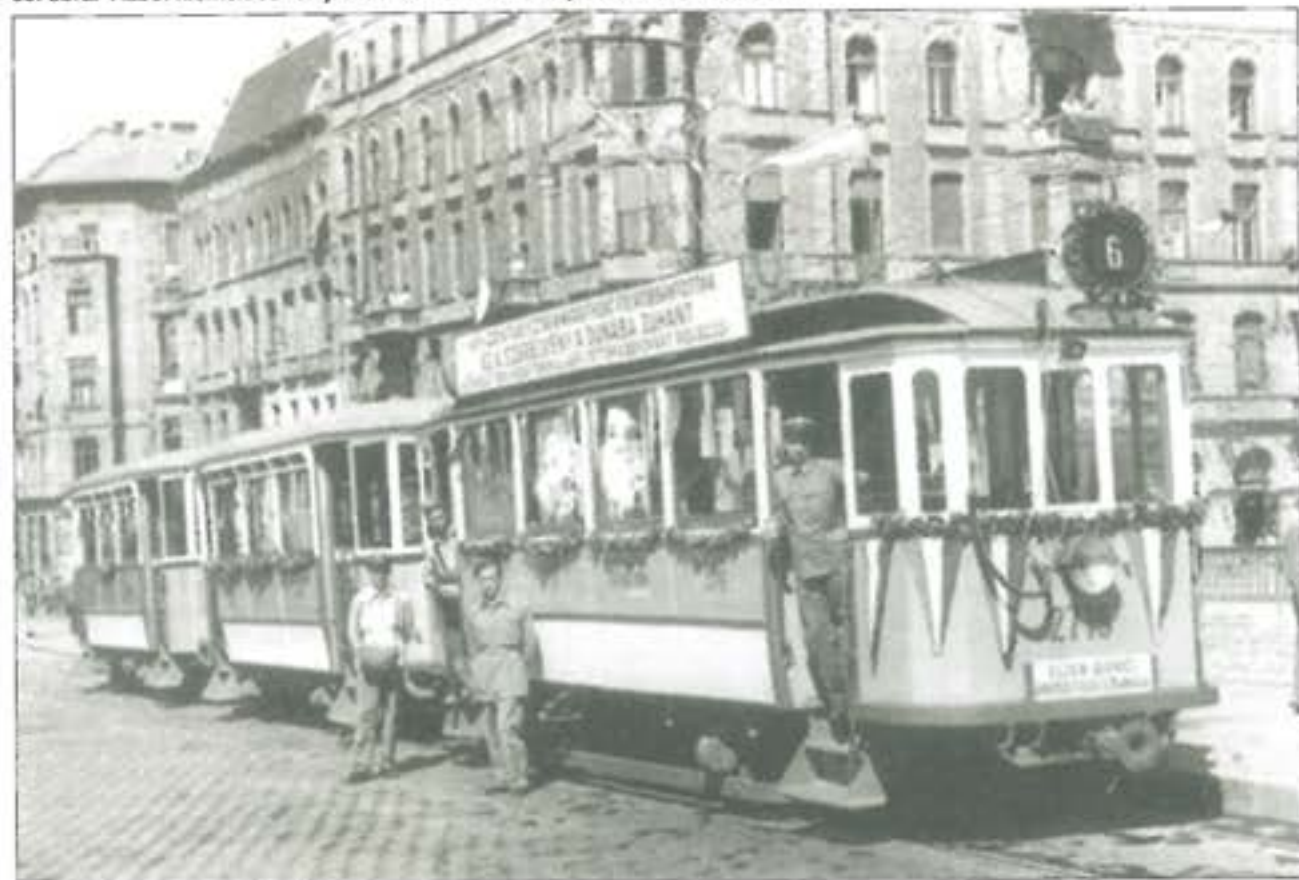
33. ábra. Vízből kiemelt és felújított villamos szerelvény készül a hídavatásra
