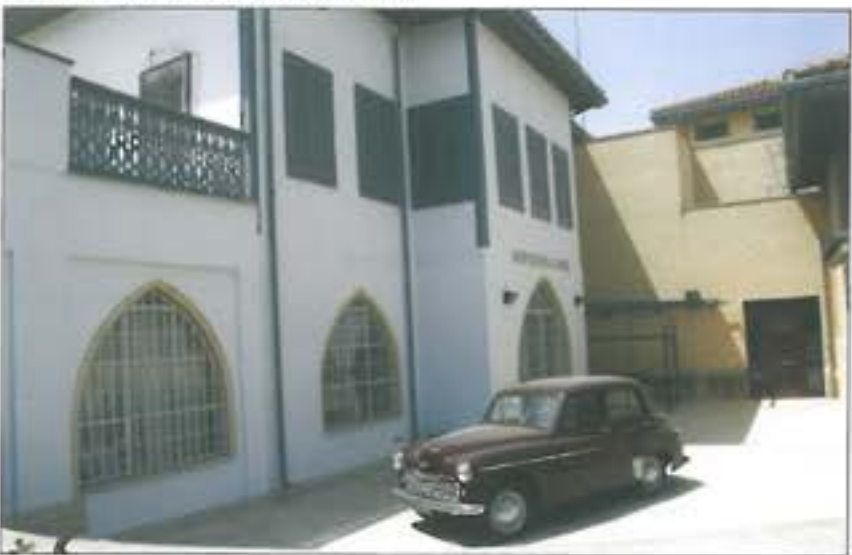
7. ábra. A múzeum épülete a bejárat felől
