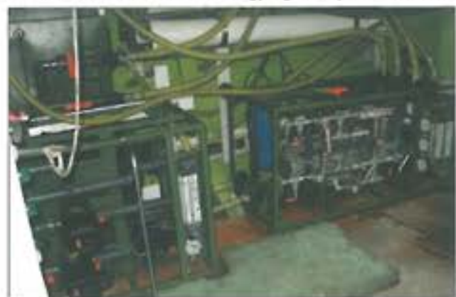
12. ábra. A Zenon víztisztító részegységei a hajó belső terében
