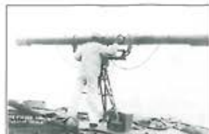
36. ábra. Távmérés 9 láb bázistávolságú Bausch & Lomb gyártmányú távmérővel az USS TEXAS fedélzetén, valamikor az első világháború után. A két tükrön keresztül látható képek összehozása a 34. ábra, illetve a 35. ábra megfelelő távolságbeállító gombjával (range knob) történik, a távolságkijelzés a mellette található mérőóráról olvasható le. Figyeljük meg, hogy az okulárok, ellentétben a B&S távmérő szabadalmaztatott 45 fokos ferde változataival, itt vízszintesen vannak kialakítva, és ezért a távmérőt magasabbra kell emelni. 102
