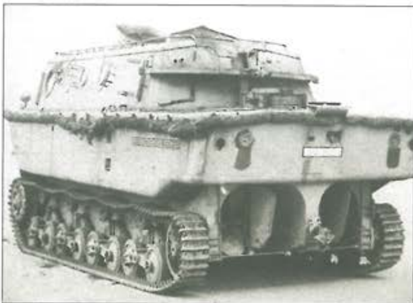
6. ábra. A hátulról készült felvételen jól látszanak a jármű vízi mozgásáért felelős hajócsavarok és kormánylapátok. A kúpfogóberendezést a hajóknál megszokott módon alakították ki
