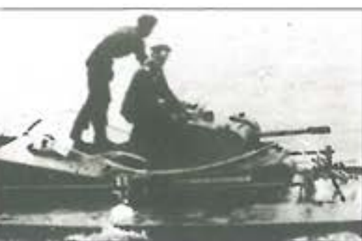
7. ábra. Schwimmpanzer II-es a próbákra történő előkészítés közben. Láthatóak a jármű oldalára szerelt úszótestek, valamint hogy a motorteret külön lemezburkolattal óvták a víz ellen
