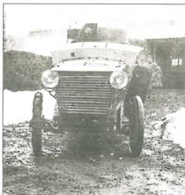
10. ábra. A jármű előlnézete az első hiddal és kerékfelfüggesztéssel
