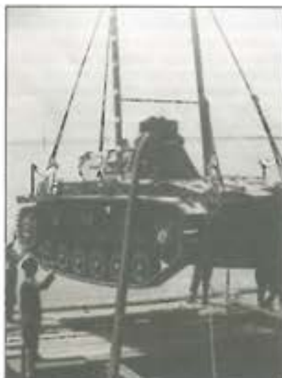
10. ábra. Miután az összes szigetelést átvizsgálták, a páncélos daruval vízbe emelik. Megfigyelhető a levegőszállításért felelős, gyűrűkkel megerősített gumicső és a tesztek idején használt vízmélységet mutató mérőléc
