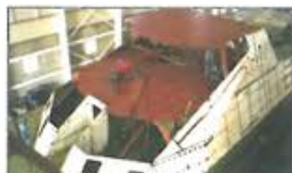
3. ábra. Építik a PAF-III-as mellő felépítményét (Blokk 501). Könnyűfém ötvözetek és műanyagok felhasználásával jelentős súlycsökkenést értek el
