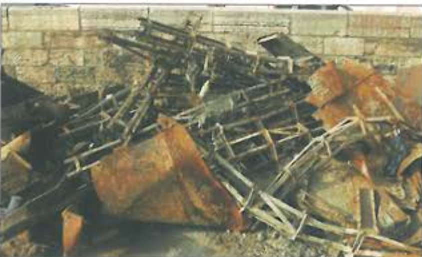
51. ábra. Ideiglenes gázcsőhid maradványai a partra kirakva 2008-ban
