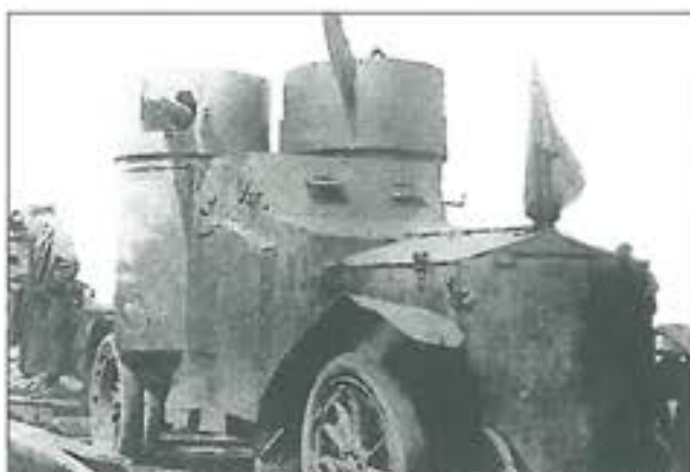
25. ábra. Az első orosz gyártású páncélgépkocsi, a Russo-Baltic-Niva, összerék-meghajtással, elői-hátul vezetőlíással, 18 mm-es páncélzattal
