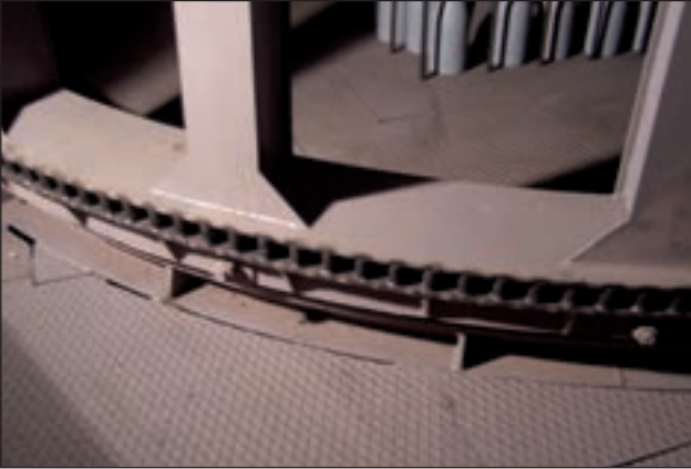
10. ábra. A torony fogasléce
