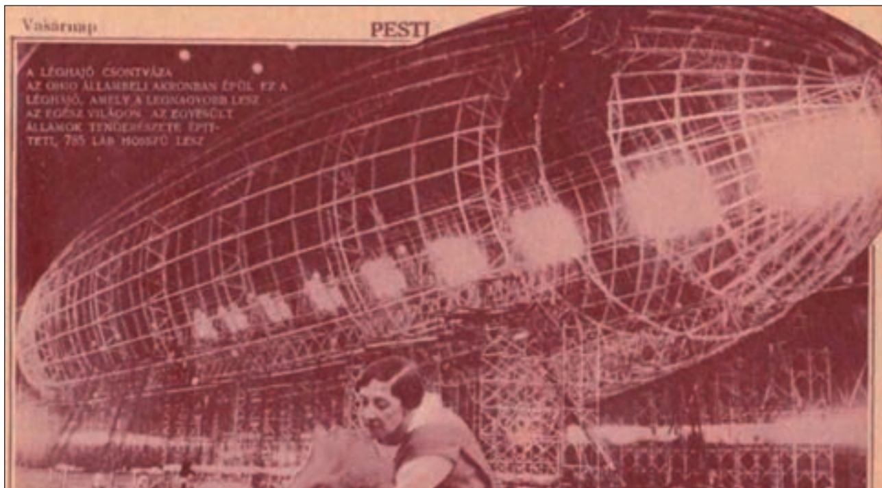
1. ábra. Az USN 239 m hosszú épülő léghajójának váza Akronban, a háború után. A rácstartó a Zeppelin rendszer erősített változata volt
