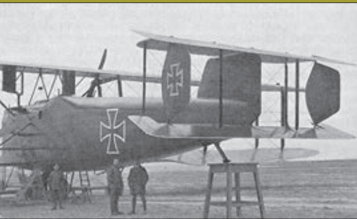
8. ábra. Azoknál a gépeknél, melyeknél nem volt szervo kormányberendezés, a hatalmas felületű kormány síkokat aerodinamikai kiegyenlítéssel építették, csuklókkal képezték ki, a mozgatásuk megkönnyítésére. E képen ez jól látszik a magassági- és oldalkormányoknál is
