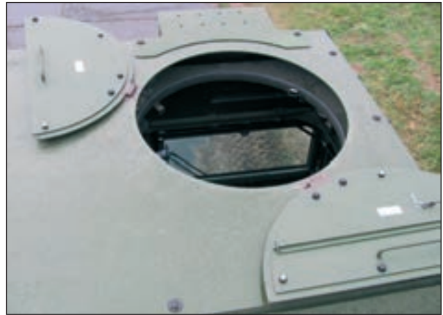
12. ábra. Tető búvónyílás kívülről
