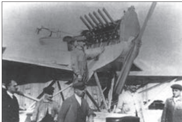
9. ábra. Az UFAG gyártású W.29-es jellegzetességei: az Austro-Daimler motor, a motorhűtő, a megfigyelő körsínes Schwarzlose M.16 géppuskaállványa. Jól látszik a vájatos falécszavar, valamint a jég és a fadarabok ellen megerősített úszótalp orra
