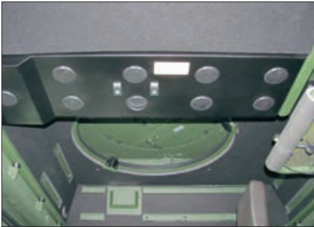
11. ábra. Tető búvónyílás és klímaberendezés
