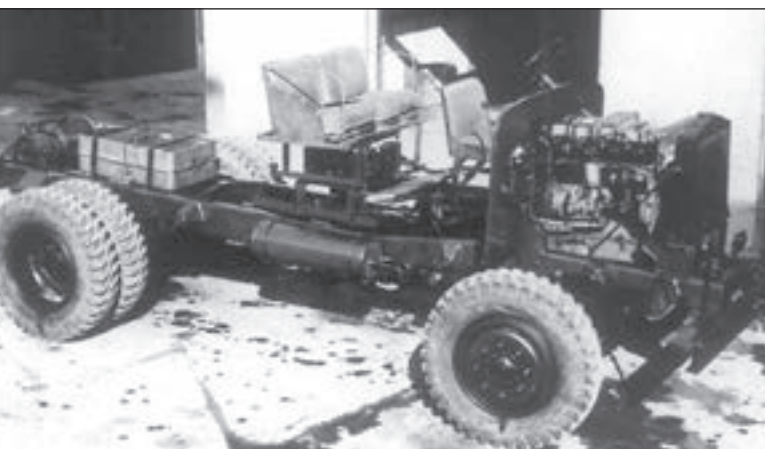
6. ábra. A Csepel 250 tehergépkocsi alváza (K.M.)
