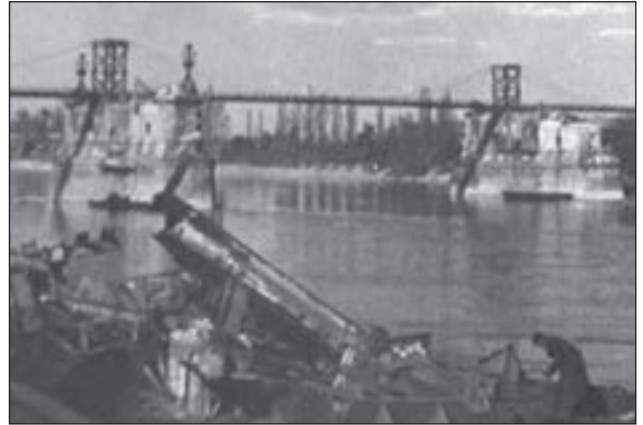
63. ábra. A gázcső-híd építésénél előkerült roncsok a parton
