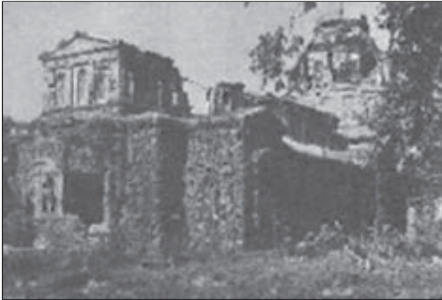
61. ábra. A sziget épületei romokban
