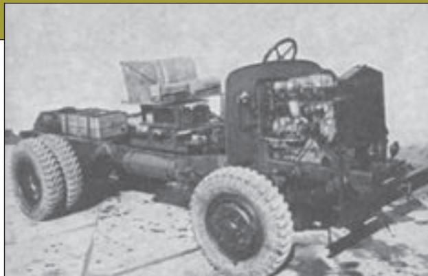
11. ábra A Csepel 250 járóképes alváza a karosszéria szerelése előtt (S.Gy.)
