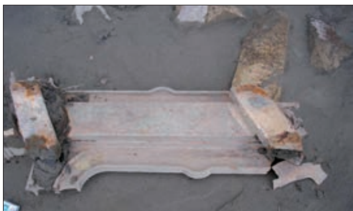
74. ábra. Az eredeti híd öntöttvas korlátarabjai a parti homokban
