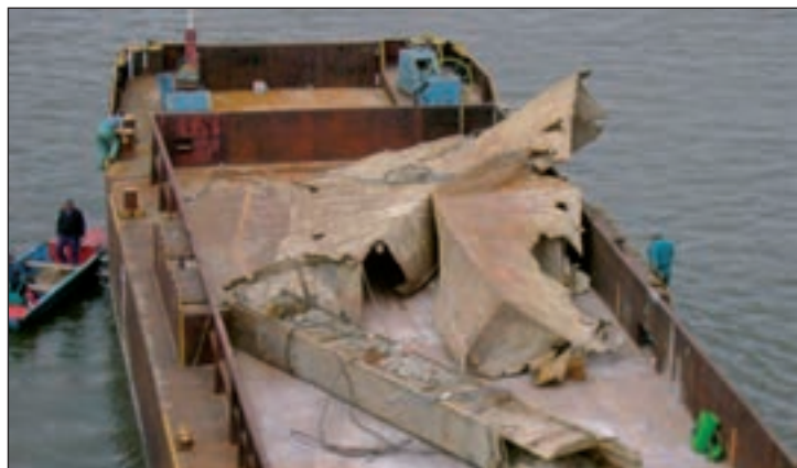
73. ábra. A híd íves tartógerince és a ponton, az uszály fedélzetén
