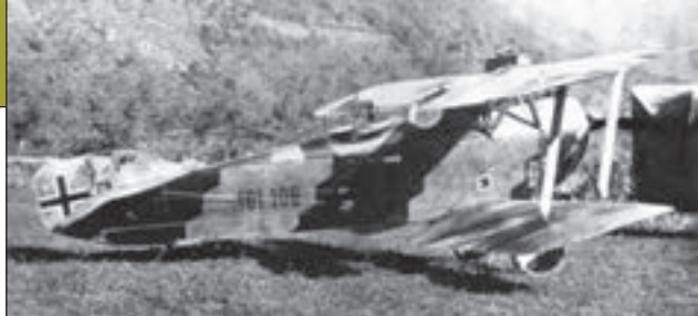
10. ábra. A Flik 4/P szolgálatában álló 161.106 jelű UCI 1918. szeptemberben már új vezérsíkkal és oldalkormányával (Grosz-Haddow-Schiemer, 294. o.)
