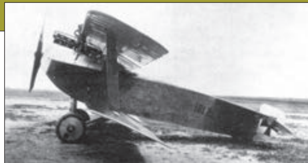
8. ábra. A 161.01-es UFAG C.I prototípus 1917 nyarán Aspernből. A gép még a keskeny, mély törzzsel, kis oldalkormányokkal és „I” alakú szárnymerevítővel épült (Grosz–Haddow–Schiemer, 291. o.)
