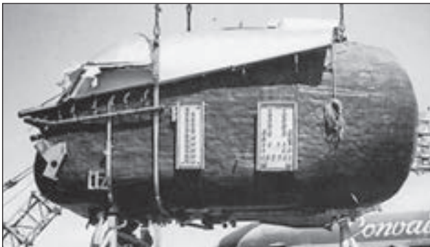
16. ábra. Az NB-36 számára kialakított 11 tonnás pilótafülke
