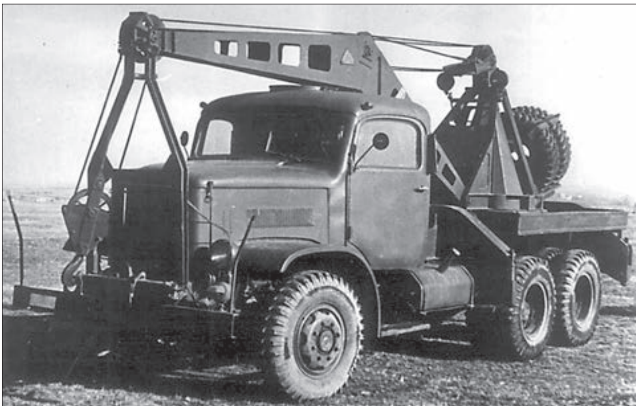
14. ábra. A K-300 gépjármű daru felépítménnyel, ideiglenes változat
