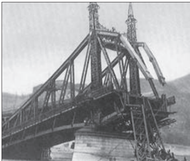
8. ábra. Az ideiglenes híd bekötő hídja, fennakadva a híd konzolos részén. A pesti rész bekötése az elsüllyedt uszályon maradt
