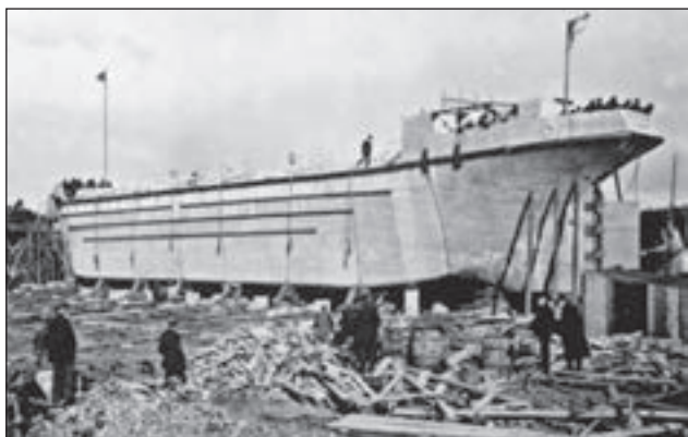
7. ábra. Betonhajó építése
