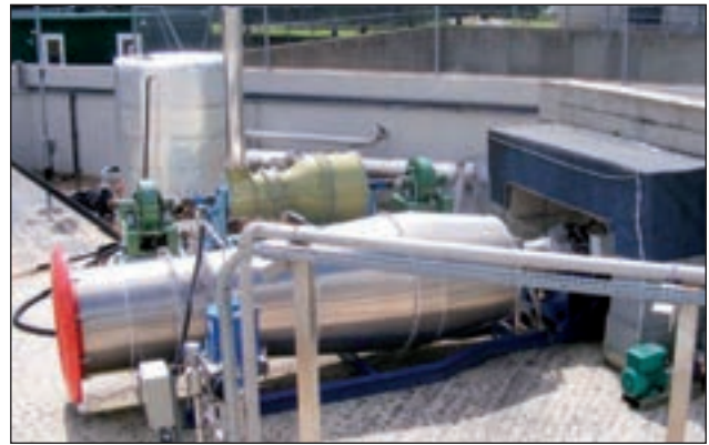
6. ábra. Tesztelés előtt a kritikus alkatrész, az előhűtő
