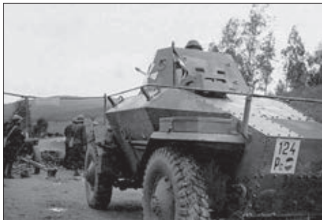
32. ábra. Jól látszik a Csaba páncélautó hat ponton rögzített, korlát-antennája.
