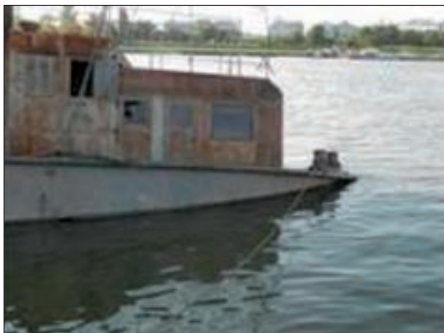
5. ábra. A belgrádi betonhajó acélból készült felépítménye
