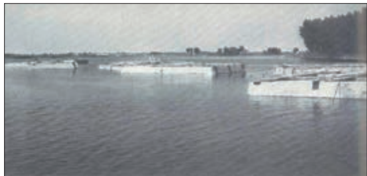
6. ábra. Betonhajó részegységek
