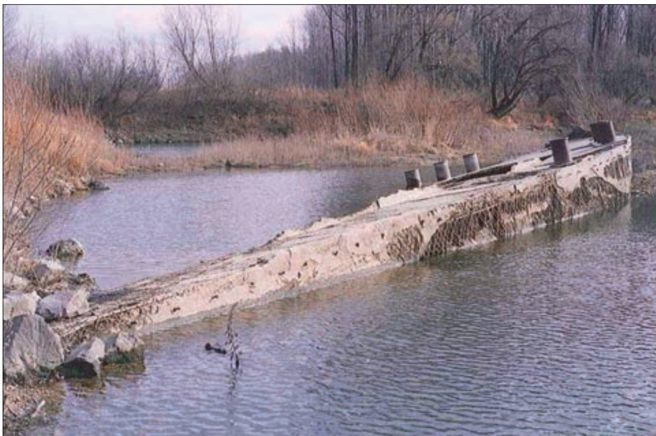
2. ábra. A betonhajó vasalása
