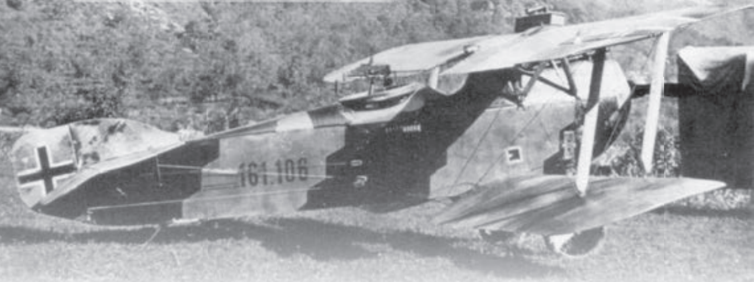
9. ábra. A Flik 4/P szolgálatában álló 161.106 jelű UCI 1918. szeptemberben már új vezérsíkkal és oldalkormányal
