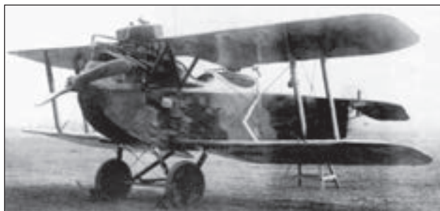
13. ábra. UFAG C.I 161.67 a Flik 23/D állományában 1918 nyarán. A szárnyak alatt 6-6 felfüggesztési pont 12,5 kg-os bombák számára
