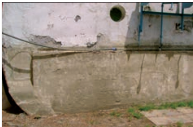
10. ábra. A hajó tört része betonnal befalazva
