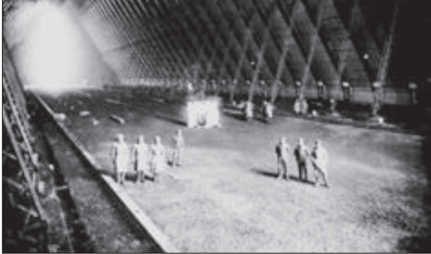
18. ábra. Készül a dekoráció az átadási ünnepséghez. Két oldalt a léghajók rögzítésére és mozgatására szolgáló kötél kocsik sinje látható
