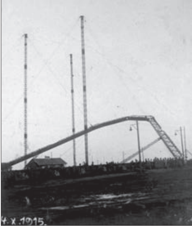
10. ábra. Felállítják a csarnok első elemét (1915. X. 14.)
