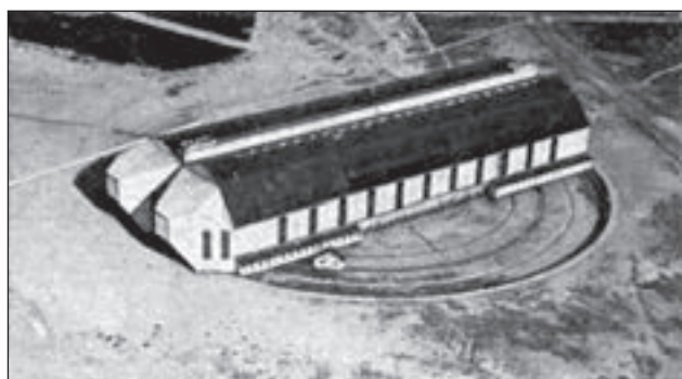
3. ábra. Forgatható, két férőhelyes léghajócsarnok Nordholzban 2
