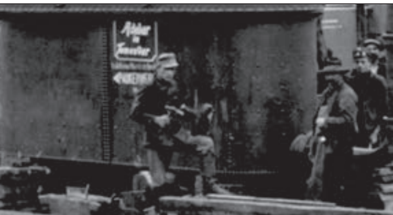
13. ábra. A felhajtóerőt adó gáz előállítására szolgáló berendezések szerelése. A nagyításon a bázis kódneve is jól látszik
