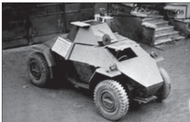
1. ábra. A tervezett páncélaútó faatrapja nyitott beszálló fedelkekkel
