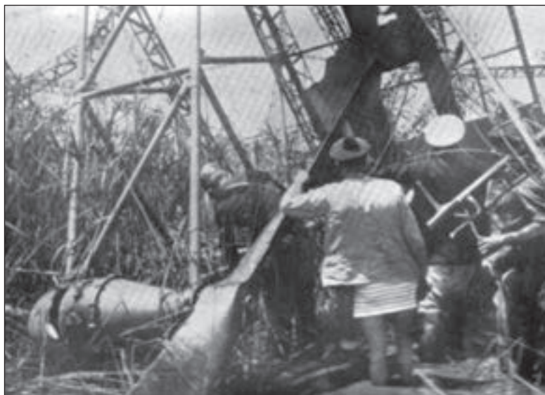
13. ábra. A roncsok közt jól látható a kétágú falégcsvár
