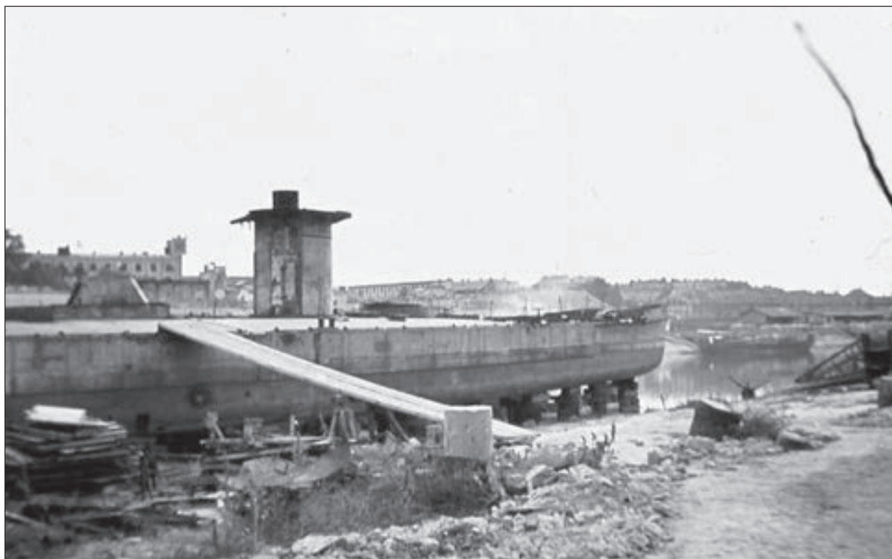
5. ábra. A monitor hajóteste és páncceltornya a hajógyári öböl partfalán, alábakolva
