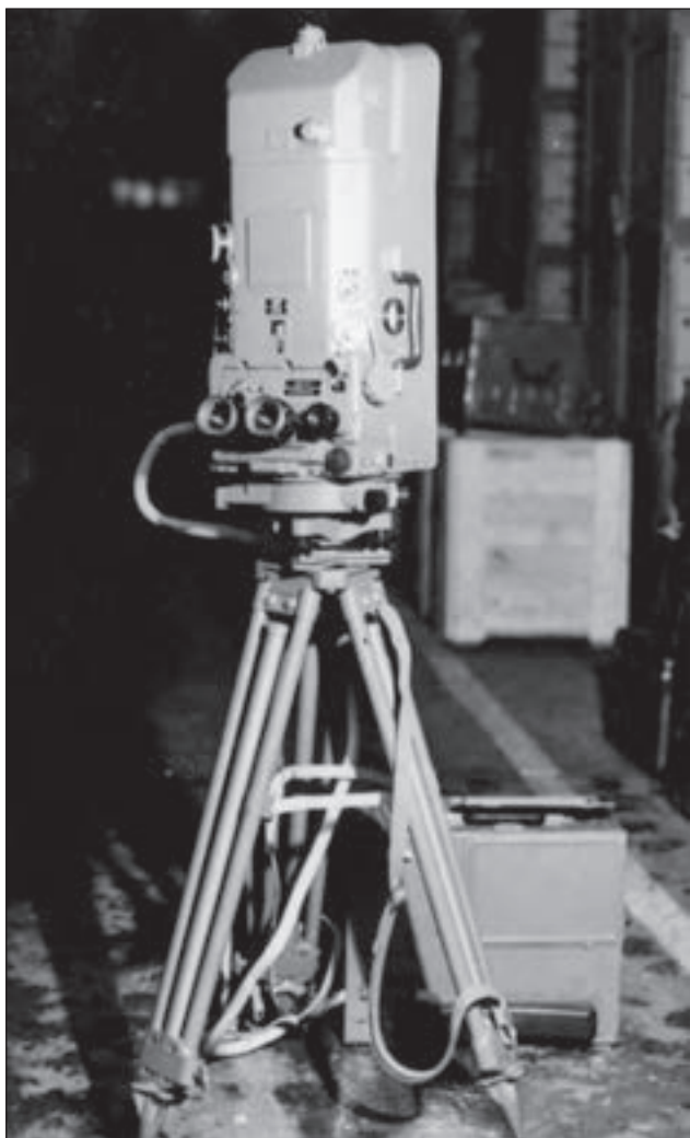
23. ábra. 1D5M lézer távmérő
