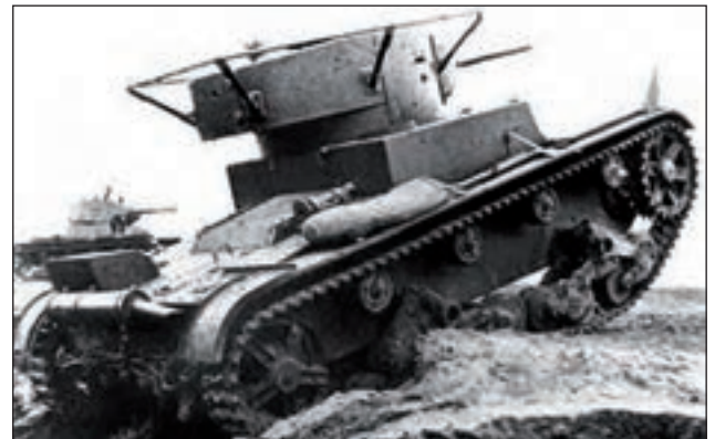
3. ábra. 1941-ben még csak kevés szovjet harckocsit láttak el az összehangolt páncélosműveletekhez elengedhetetlen rádióval, fejlett optikai célzóberendezéseket pedig ekkor még nem tudott előállítani a szovjet ipar, csak egyszerű monokuláris irányzékokat
