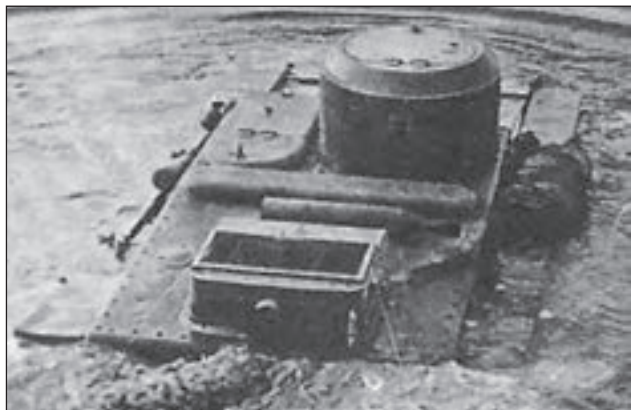
5. ábra. Az 1942-ig nagy számban rendszerben tartott, mindössze kétszemélyes T-37 kisharckocsi úszóképes volt ugyan, ám egyetlen 7,62 mm-es géppuskából álló fegyverze- te csak felderítési feladatokra tette alkalmassá, a német páncélosok elleni küzdelemre nem
