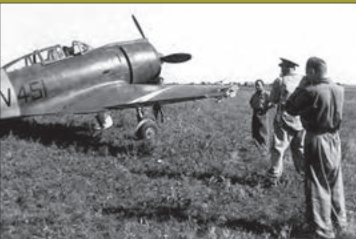
5. ábra. A sebesült Pittenbacher által visszahozott, „baráti tűz” áldozatául esett, sérült V.451-es gép. A szárnytónél a mindegyik Héjára felszerelhető fotógéppuska 4 db felerősítő bakja látszik. A gép oldalán a fekete Venturi csövön látható egy előremutató fehér nyíl, amelyik a felszerelési irányt mutatja
