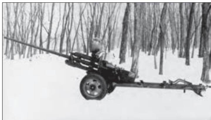
3. ábra. 57 mm-es ZiS-2 43M páncéltörő ágyú éjszakai irányzóval. Maximális lőtávolsága 8400 m, löszere egyesített, egy javadalmazás 200 db. Páncélátütő képessége 90°-on 500 m-ig 103 mm, 1000 m-ig 91 mm. Önsúlya 1250 kg. Vontatása gépjárművel, vagy 6 lovas löveg mozdonnyal. Rendszerben: 1950-től, 1963-tól APN-3–55 éjszakai irányzó berendezéssel
