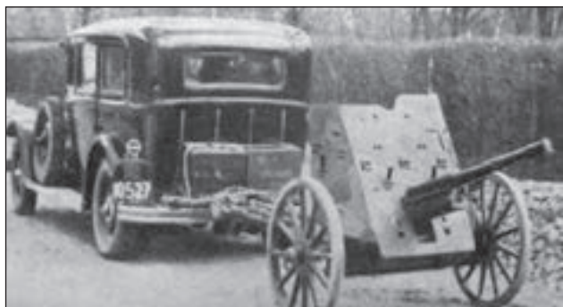
3. ábra. A Fancsikánál eredményes 1936M 3,7 cm-es páncéltörő ágyú civil bérgepkocsiját vontatmányában (eredetileg fogatolt löveg, a küllős kerekek jól láthatóak) (Móricz)
