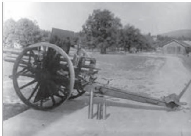
4. ábra. 1905/08M 8 cm-es fogatolt tábori ágyú – még az 1920-as években is használt – időzíthető gyújtóval szerelt srappelvekkel, illetve a hüvelytölténnyel
