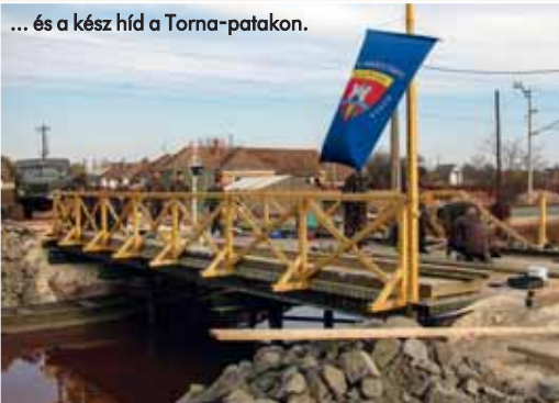
... és a kész híd a Torna-patakon.
