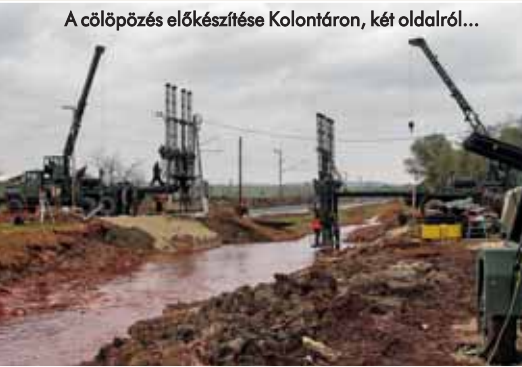
A cölöpözés előkészítése Kolontáron, két oldalról...
