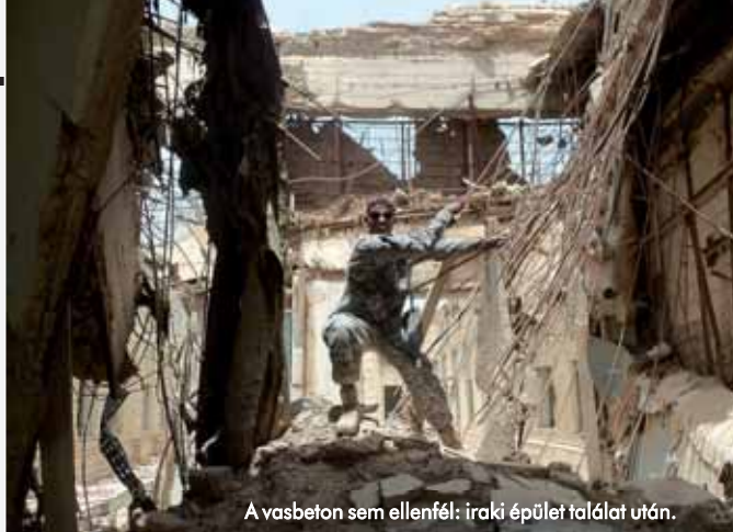
A vasbeton sem ellenfél: iraki épület találat után.
