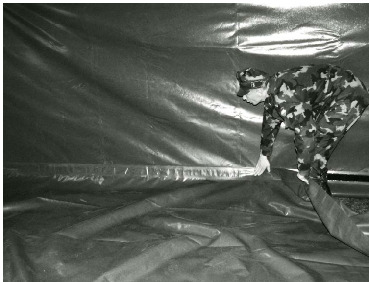
7. ábra – Aljzatfólia felcsatolása
