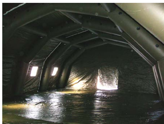
10-11. ábra – TMM jelű, többcélú 105 m 2 alapterületű bővíthető sátor
