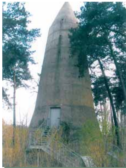
EGY SZIVAR ALAKÚ BUNKER A BÁZIS TERÜLETÉN
