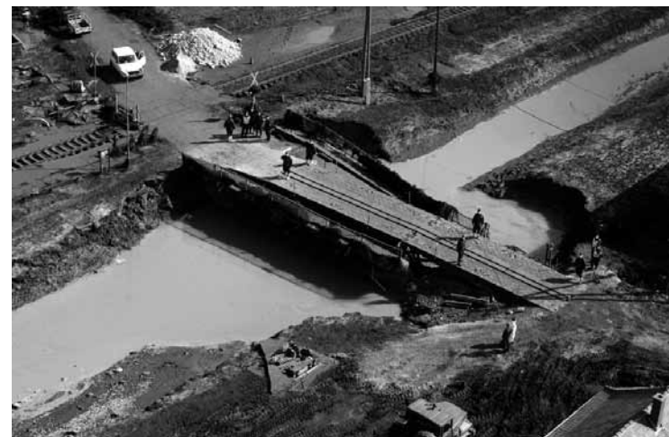
A Magyar Honvédség által néhány napon belül felépített pontonhíd
