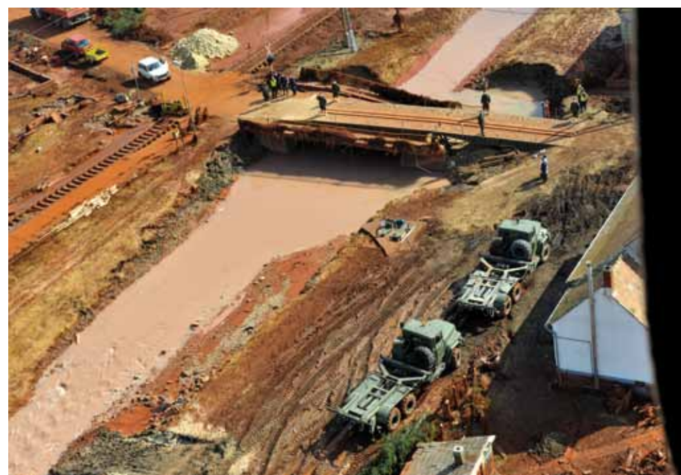
A Magyar Honvédség által néhány napon belül felépített pontonhíd
