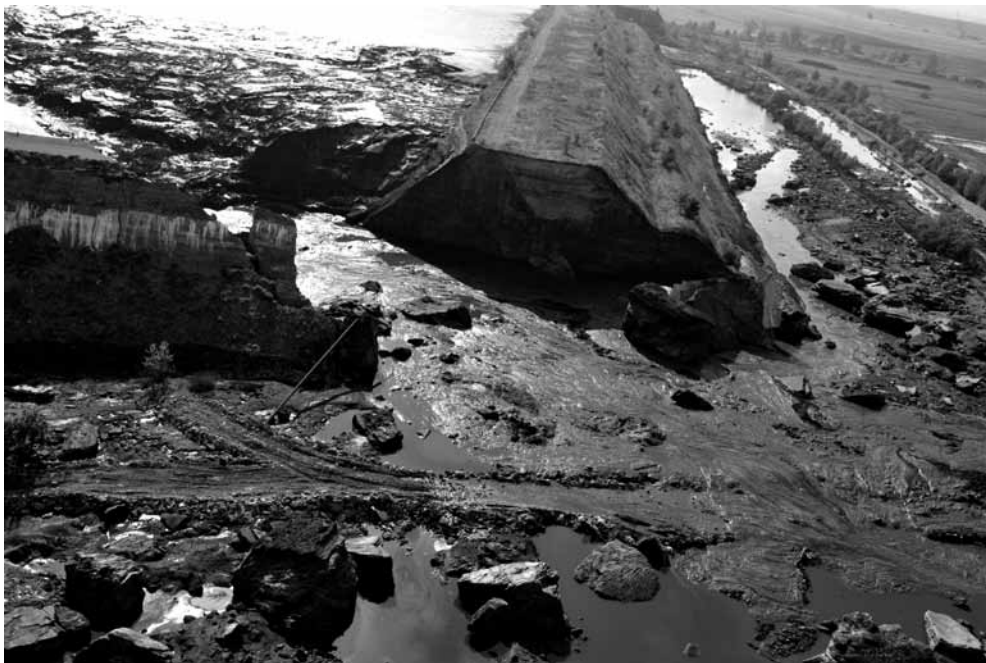
A X. tározó átszakadt északnyugati sarka
