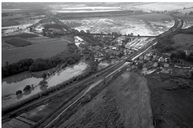
Kolontár és a zagytározók közötti szakasz
