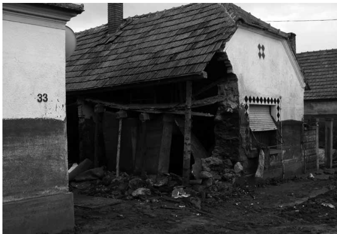
Súlyosan megrongálódott ház, ahol a tulajdonost holtan találták a katasztrófa után
