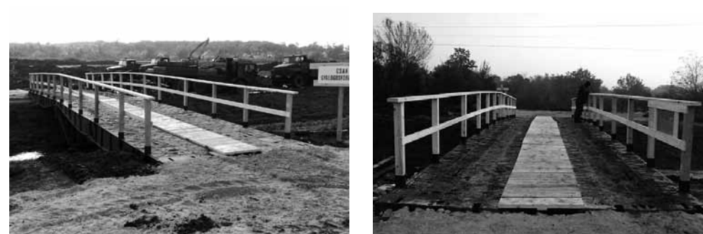
Gyalogos-közlekedésre alkalmas híd Kolontáron, Devecsér irányában
