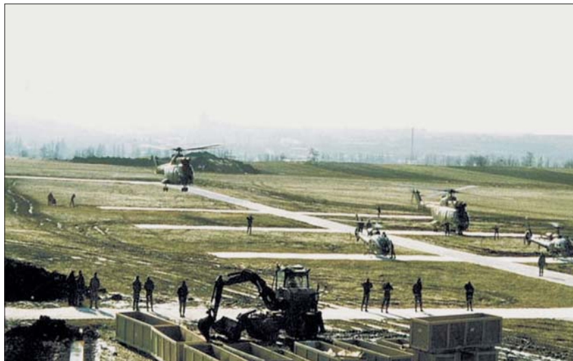
63. számú kép: Geotextília használata helikopterleszálló helyen
