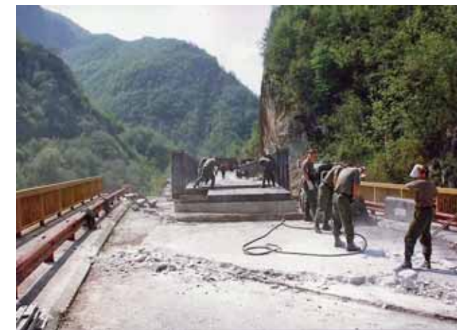
MABEY & JOHNSON HÍD TELEPÍTÉSI MUNKÁITAI
